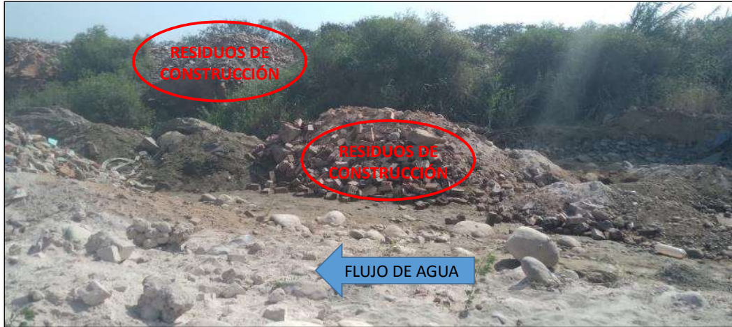
FIGURA N°01: RIO CHANCAY - HUARAL COLMATADO EN EL SECTOR PUENTE LA HUACA, CON LA PRESENCIA DE RESIDUOS DE CONSTRUCCIÓN Y OTROS, EN AMBAS MARGENES DEL RIO, OCASIONANDO LA REDUCCIÓN DEL ÁREA HIDRÁULICA SUSTANCIALMENTE, LA CUAL PRODUCE EL DESBORDE DEL RÍO HACIA AMBAS MARGENES.
