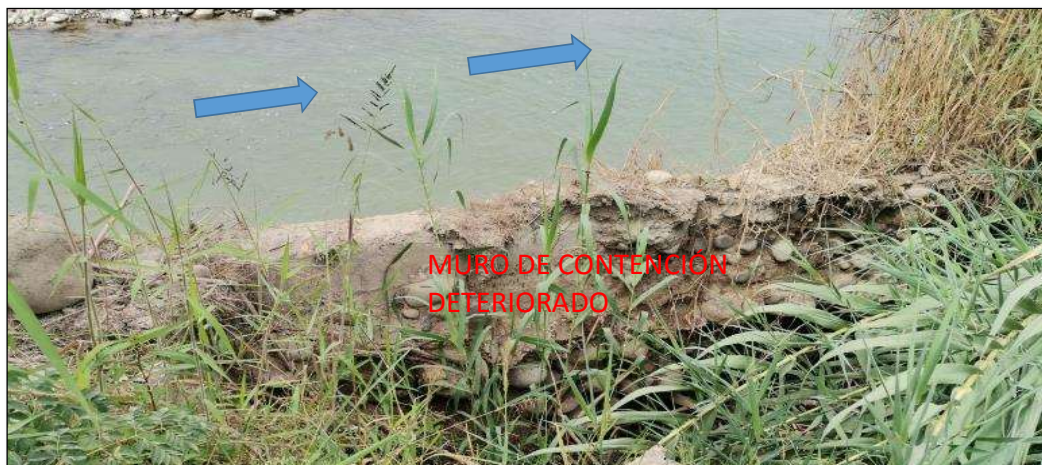
FIGURA N°04: MARGEN DERECHA DEL RIO CHANCAY - HUARAL PRESENTA MURO DE CONTENCIÓN DETERIORADO EN EL SECTOR BOCATOMA CHANCAY HUARAL DEL DISTRITO HUARAL - AUCALLAMA, POR TAL MOTIVO ESTE TRAMO ES VULNERABLE A LA ACCIÓN EROSIVA DEL CAUCE DEL RIO, CAUSANDO DESBORDAMIENTO EN ZONAS ALEDAÑAS EN EPOCAS DE AVENIDAS.
