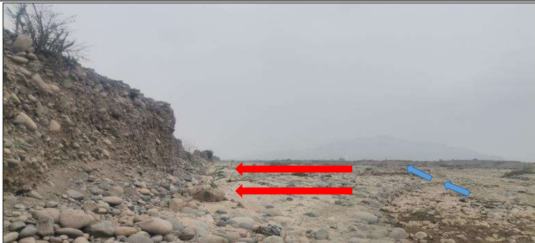
FIGURA N°02: MARGEN IZQUIERDA DEL RIO CHANCAY - HUARAL CON DIQUE DE PROTECCIÓN EN MAL ESTADO, POR TAL MOTIVO ES VULNERABLE A LAS VELOCIDADES EROSIVAS DEL RIO PRODUCIENDO DESBORDES DEL CAUCE DEL RIO, EN EL SECTOR BOCATOMA CHANCAY - HUARAL DEL DISTRITO DE HUARAL - AUCALLAMA.
